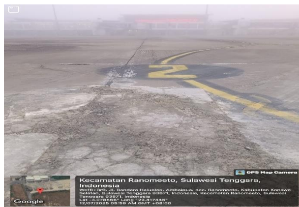
Gambar 2. Kondisi Apron Mengalami Kerusakan Permukaan dan Potensi FOD
