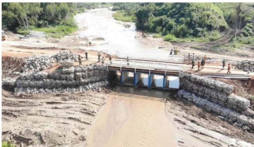
Gambar 2. Jembatan yang telah dibangun oleh Kompi Zeni
